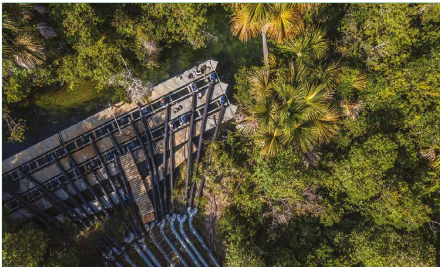
Fig. 4 : Installation de pompage de l'eau superficielle dans une grande propriété de l'extrême ouest Baianais (près des sources de l'Arrojado). Source : D. Galdieri @Hilaea Media (2021).
